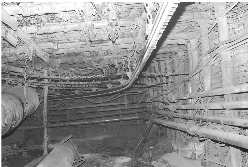
Rys. 9.6 Skrzyżowanie (załamania) chodnika przyścianowego w obudowie ŁProj
