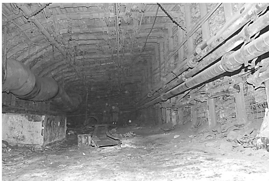
Rys. 9.5 Chodnik przyścianowy w obudowie ŁProj
