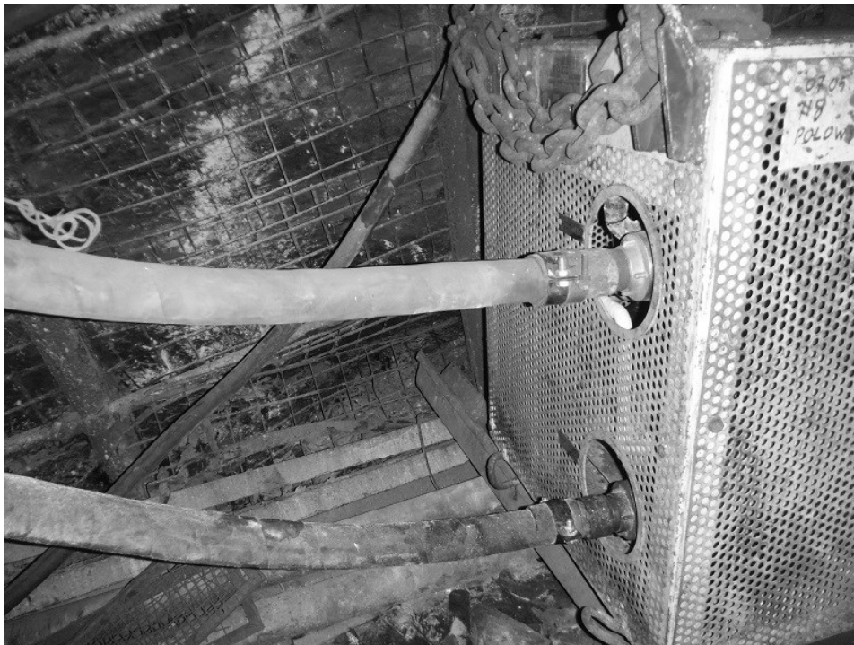
Rys. 47.4 Doprowadzenie i odprowadzenie azotu do Górniczej Chłodziarki Azotu
