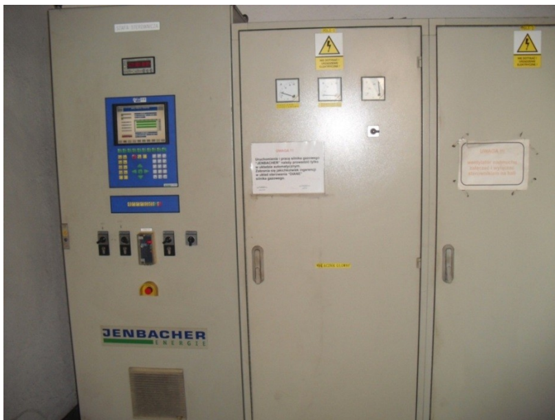
Rys. 12.4 Szafa sterownicza agregatu prądowórczego
