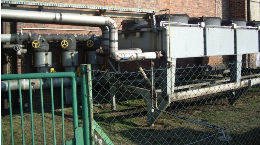
Rys. 12.6 Chłodnia wentylatorowa wody powrotnej dla agregatu prądotwórczego
