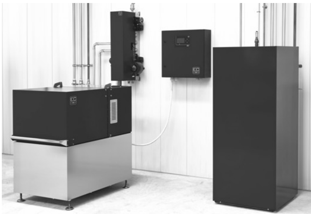
Rys. 16.2 Zestaw gazowej mikrogeneracji MCHP XRGI
