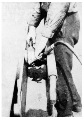
Rys. 34.4 Prostowanie zwężenia półki zastawki
