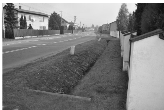
Rys. 13.5 Miejsce pomiarów względem drogi
