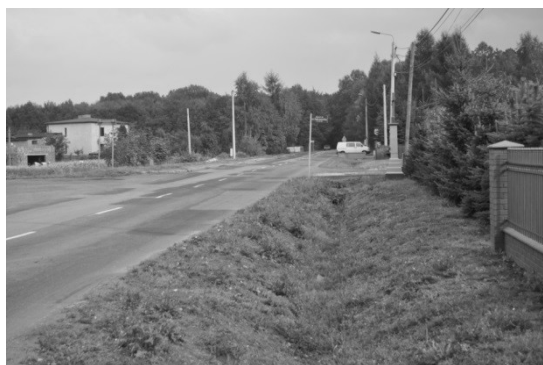
Rys. 13.3 Miejsce pomiarów względem drogi
